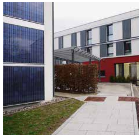
Studentenwohnanlage „Eisberg“, Amberg
